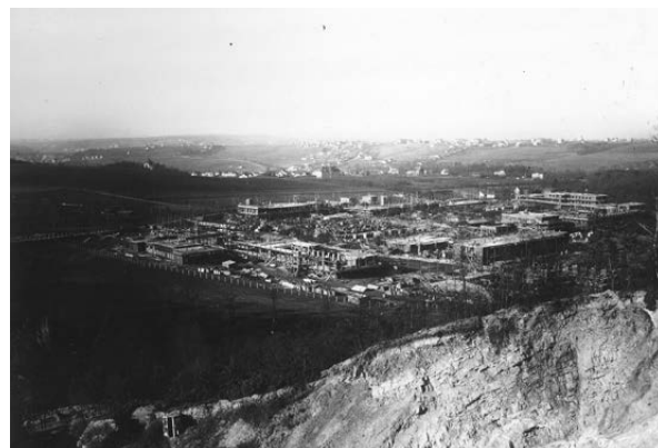
Obr. 2 Pohled stavbu od východu 30. srpna 1926.
